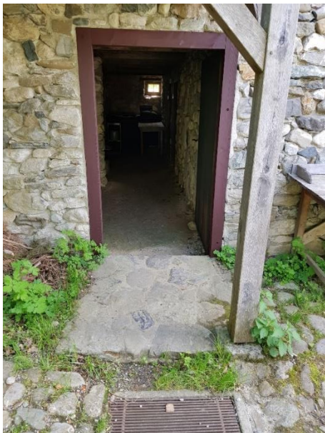
Keller Tür: 99 cm, Schwelle: 8,5 cm außen, 16 cm innen
