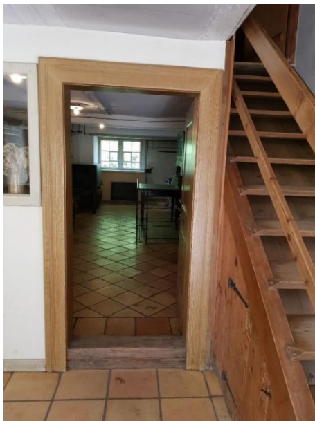
Küche Tür: 78 cm, Schwelle: 13 cm
