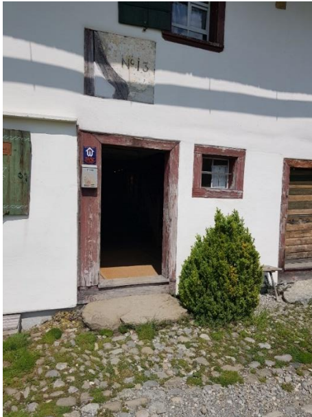
Eingang Wohnhaus Tür: 85 cm, Schwellen: 10 und 18 cm
