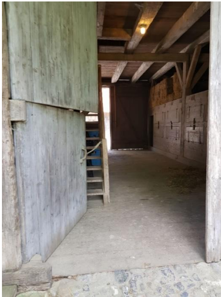
Zugang vom Haus Füssinger Tor: 175 cm, ohne Schwelle
