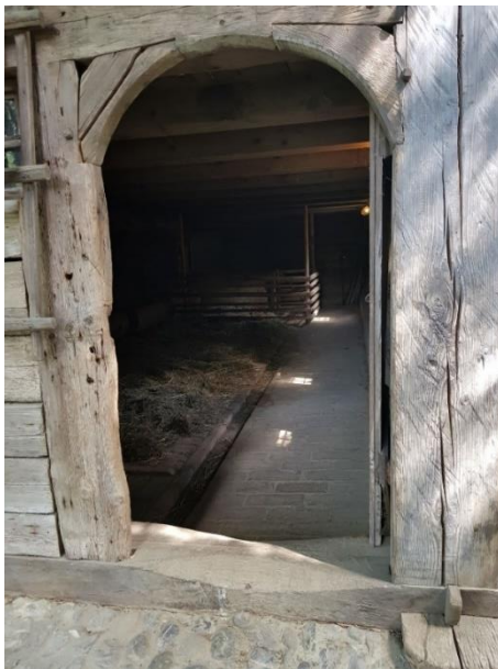
Stall Tür: 96 cm, Schwelle: 21 cm außen, 26 cm innen
