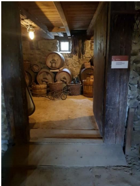
Mostkeller Tür: 108 cm, Rampe mit Schwelle 2 cm außen, 5 cm innen
