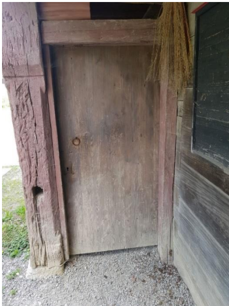
Zugang Wagenremise Tür: 83 cm, keine Schwelle, Kiesboden momentan geschlossen
