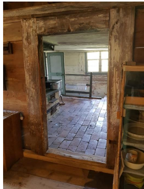
Küche Tür: 83 cm, Schwelle: 7-11 cm
