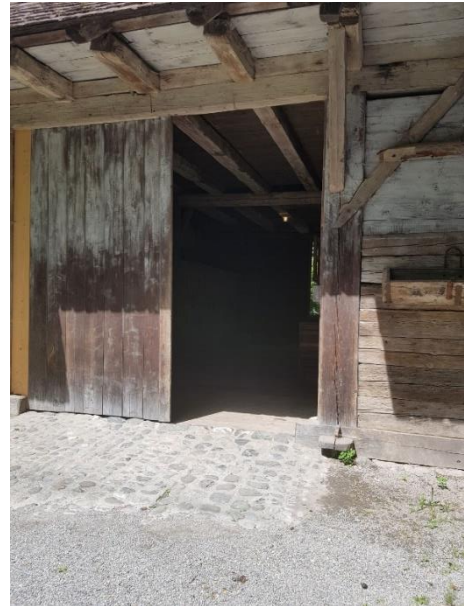
Zugang vom Fischerschopf Tor: 180 cm, ohne Schwelle
