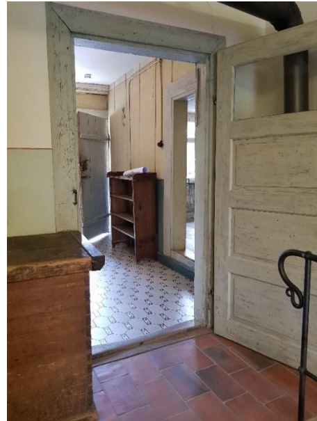
Durchgang zum Flur Tür: 89 cm, Schwelle 2-4 cm
