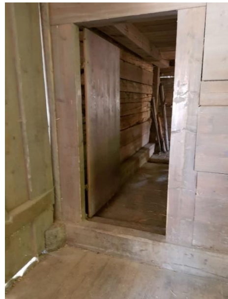
Übergang Stall / Tenne Tür: 80 cm, Schwelle: 21 cm innen, 11 + 4 cm innen
