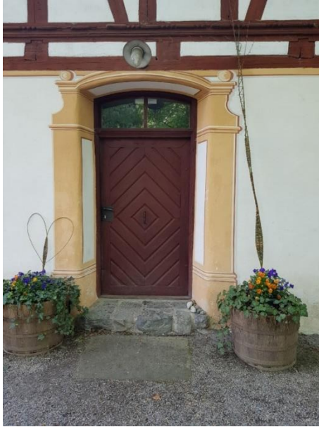
Eingang Gaststätte Tür: 101 cm, Schwelle: 15 cm
