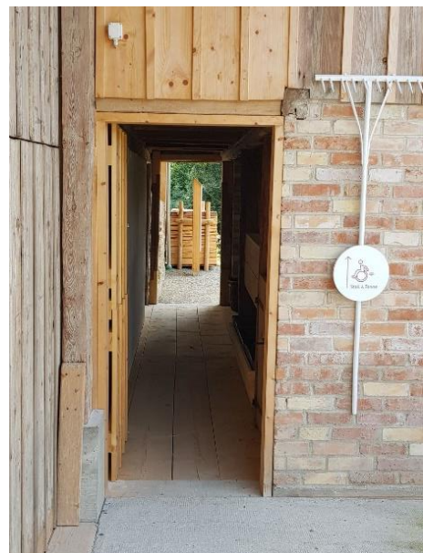
Schweinestall Türen: 80 bzw. 87 cm mit Schwelle 4 cm
