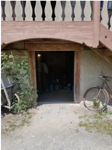
Zugang Keller Tür: 123 cm
