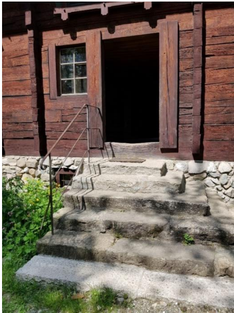
Vordereingang Über 6 Stufen und eine Schwelle zugänglich
